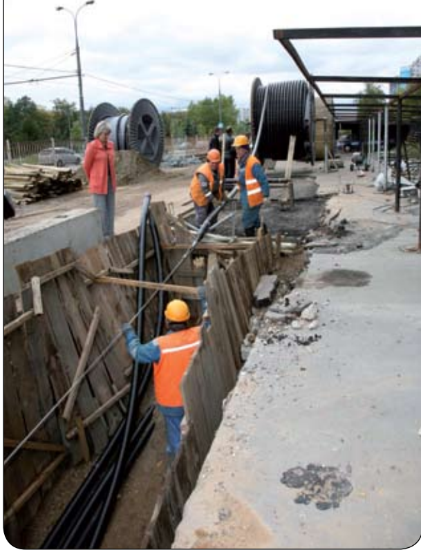
Прокладка кабеля на Рублевском шоссе
