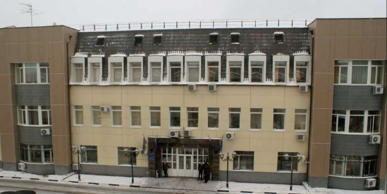
Административно-офисное здание ОАО «МОЭСК»
