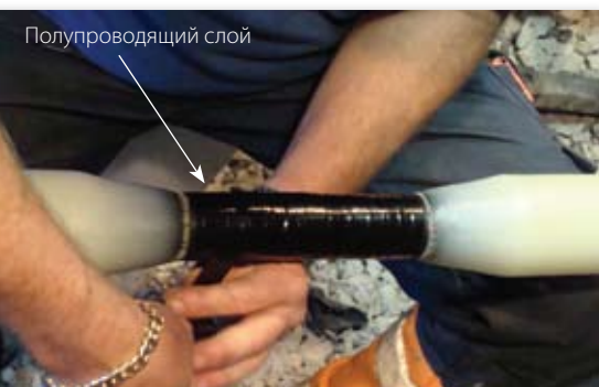
Восстановление изоляции
