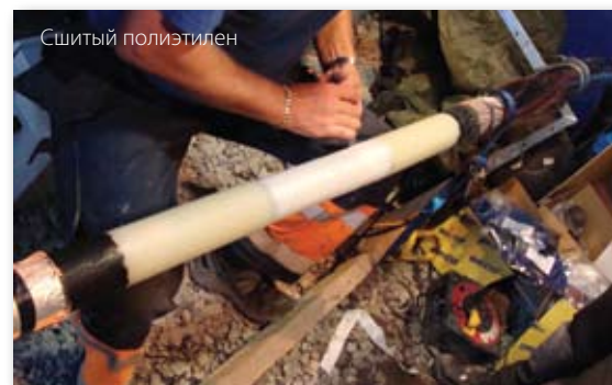
Завершающий этап работы, восстановление конструкции кабеля
