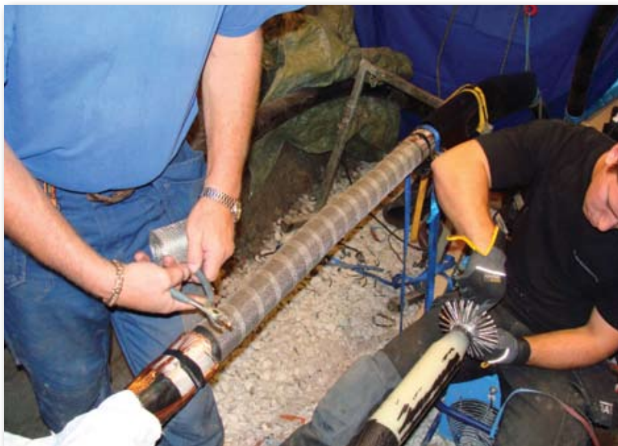
Сращивание происходит под высокой температурой и давлением с помощью специального оборудования
