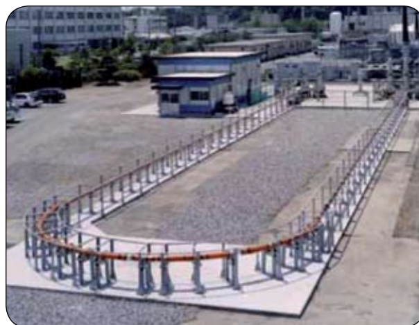
Рис. 11. Испытания ВТСП кабеля SEI, Япония
