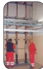
Рис. 9. Монтаж концевых муфт ВТСП кабеля NKT Cables на подстанции АМК, Дания
