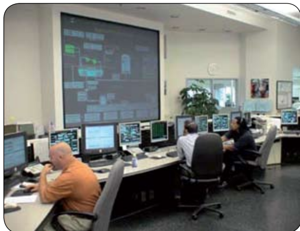
Рис. 18. Удаленный мониторинг системы криогенного обеспечения ВТСП КЛЭП в г. Олбани
