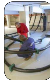
Рис. 10. Монтаж ВТСП кабеля NKT Cables длиной 30 метров на подстанции АМК, Дания
